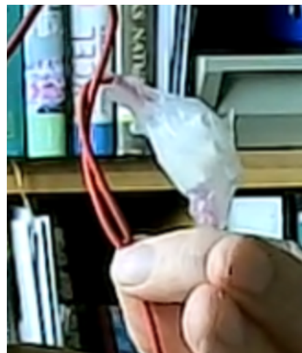
Figur 7: Forbindelse sikret med ledende epoxy
